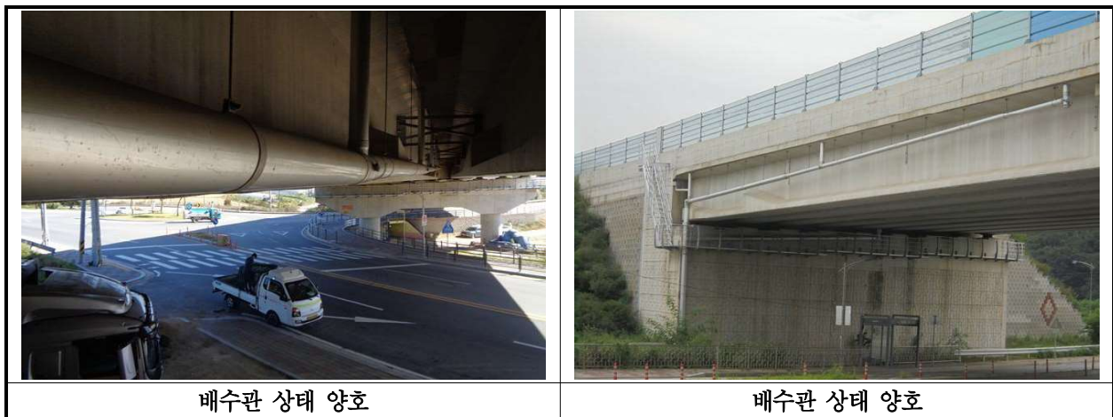
【사진 33.3.22】 배수시설 손상현황
