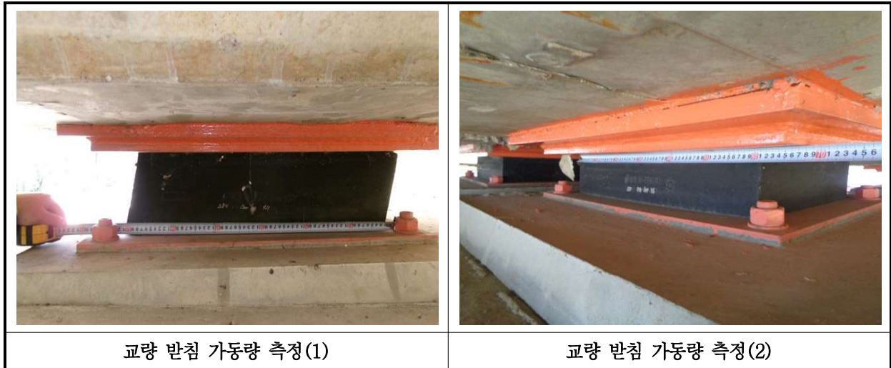
【사진 33.3.15】 교량받침 이동량 측정
