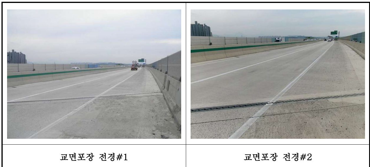
【사진 33.3.19】 교면포장 전경
