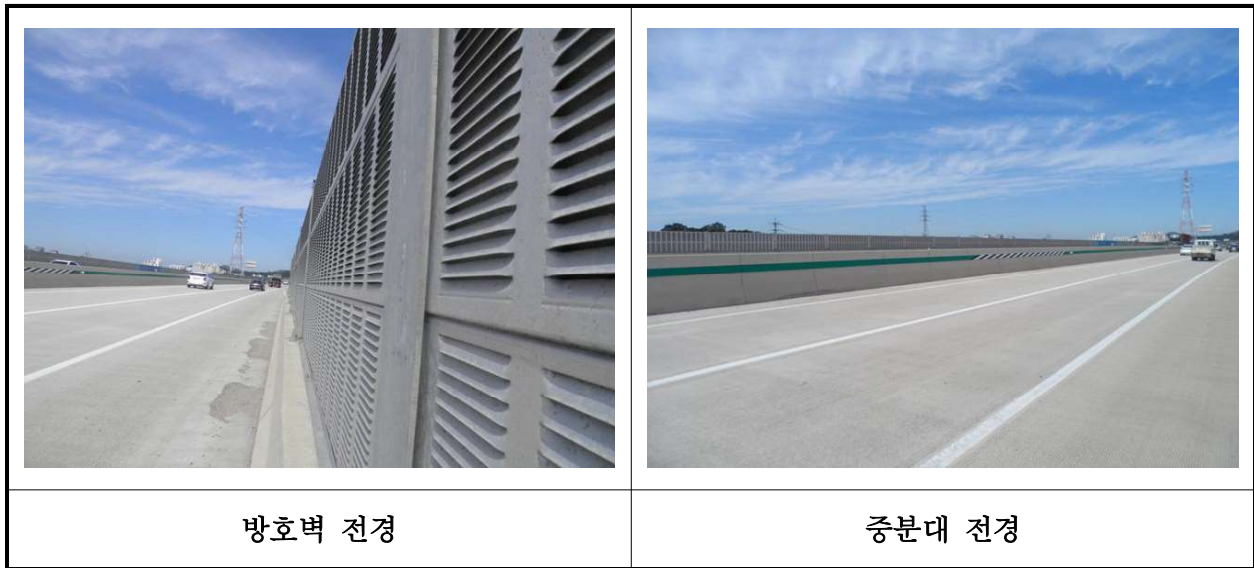
【사진 33.3.23】 방호벽 및 중앙분리대 전경
