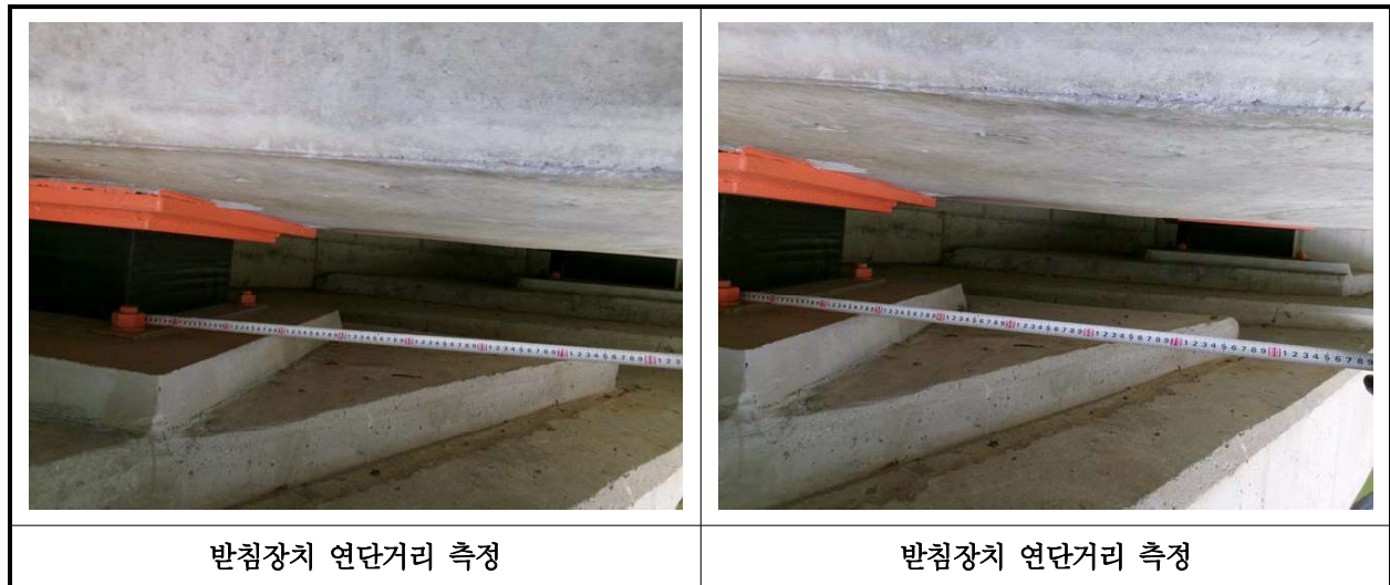
【사진 33.3.14】 교량반침장치 연단거리측정
