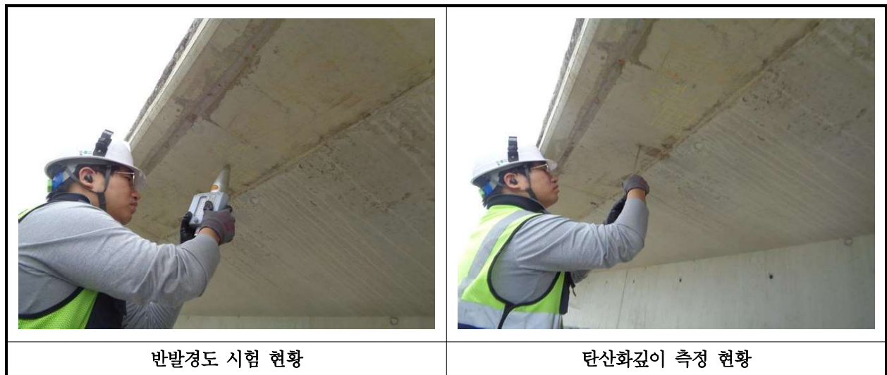
【사진 33.4.1】 콘크리트 내구성조사 현황
