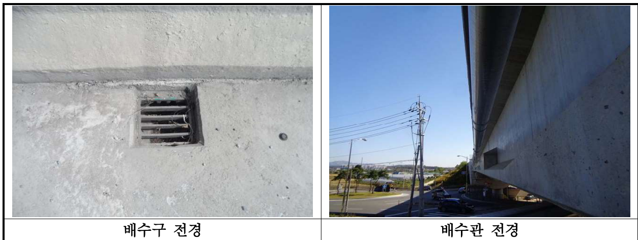
【사진 33.3.21】 배수시설 전경
