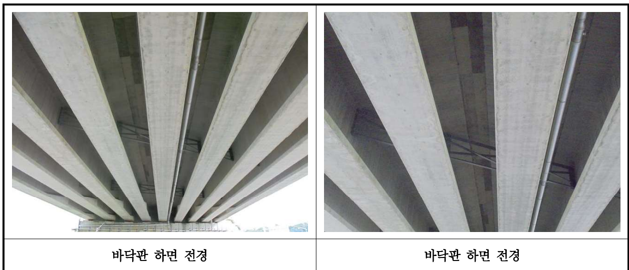
【사진 33.3.2】 바닥판하면 전경
