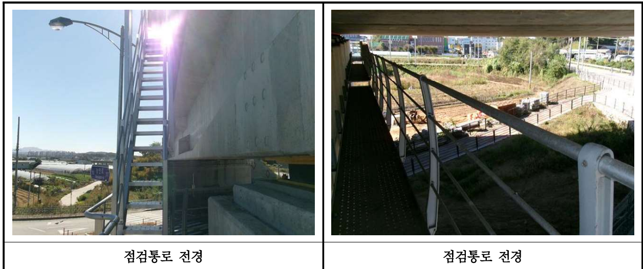
【사진 33.3.25】 교량 점검시설 전경
