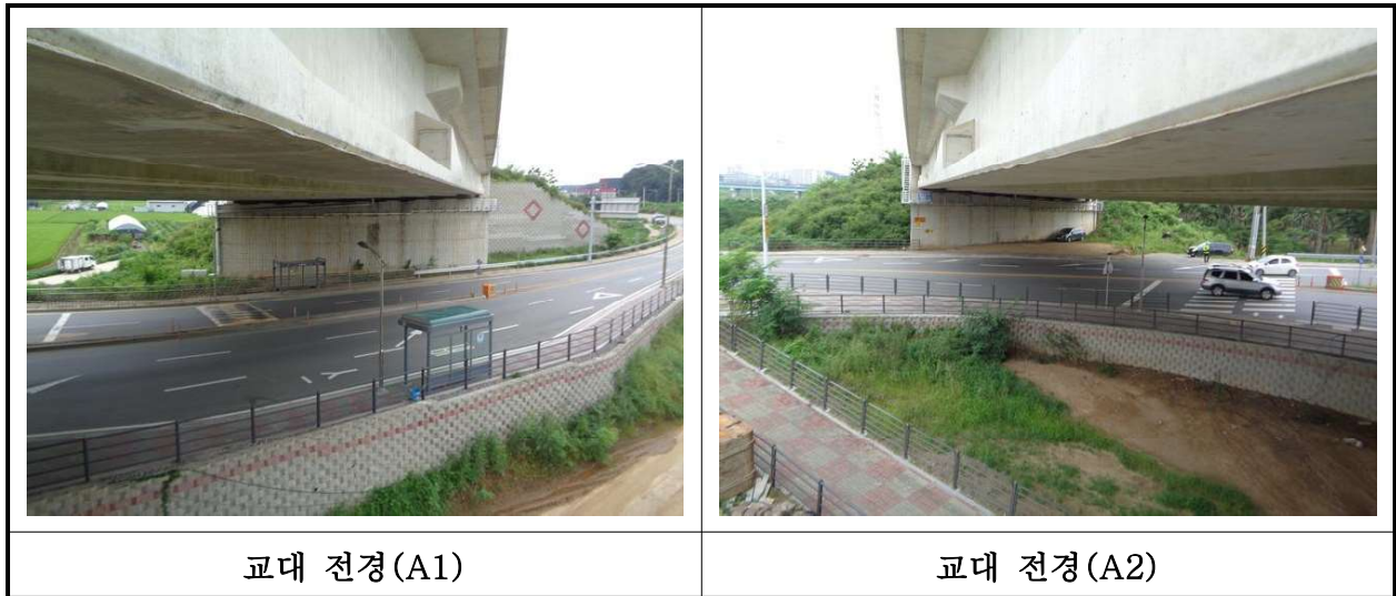
【사진 33.3.8】 교대 전경
