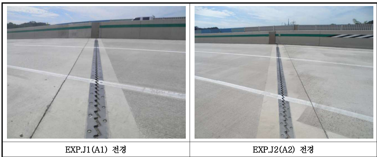
【사진 33.3.16】 신축이음장치 전경
