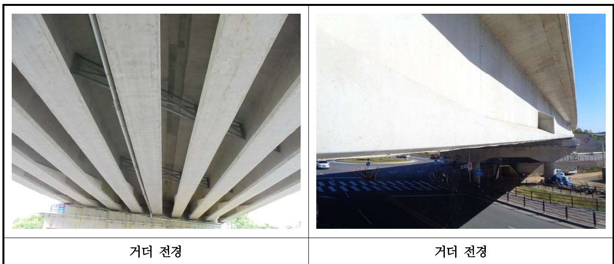
【사진 33.3.4】 거더 전경
